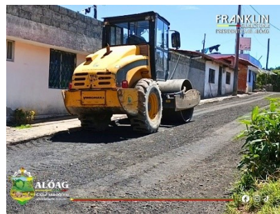
Pasaje S/N del barrio El Cortijo se realizó el tendido de subbase y su respectiva compactación.
