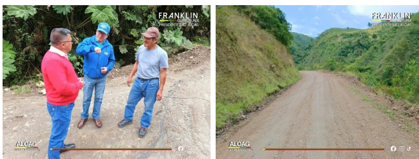
Mantenimiento vial en el barrio San Juan de Quitasol
