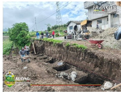
Construcción de muro de contención en el barrio el Corazón.
