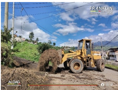
Limpieza del derrumbe del talud en la vía Aychapicho – Alóag, con la maquinaria del GAD Parroquial.
