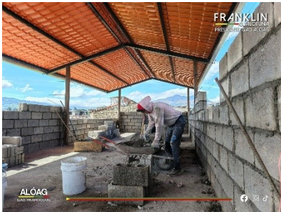
Construcción del segundo piso de la sede de “Los Coqueros”
