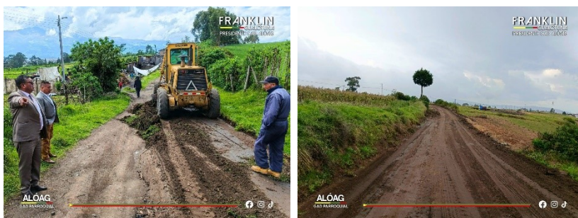
Mantenimiento vial en el barrio El Corazón
