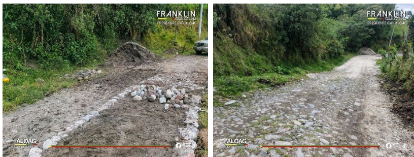
Reempedrado de la segunda entrada al barrio La Libertad.
